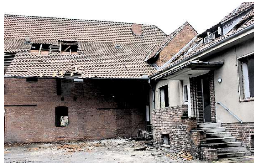
Rückblick: Noch vor wenigen Tagen stand hier das Wohnhaus.
