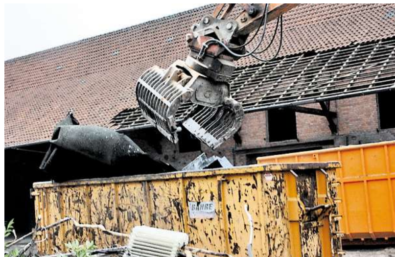
Sobald der Abriss geschafft ist, beginnt der Neubau – planmäßig im April.
